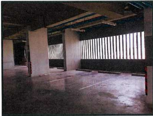
รูปที่ 3-4 ช่องเปิดสำหรับระบายอากาศบริเวณชั้นล่างถึงชั้นที่ 7
